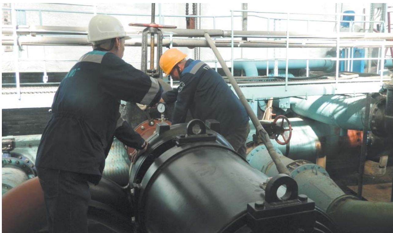
Рис. 5. Машинный зал ГКНС в ходе реконструкции. Монтаж нового насоса
